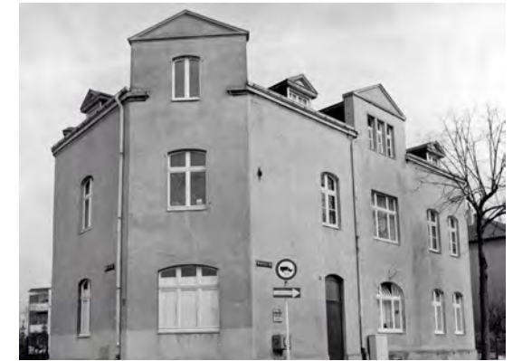
Das Verwaltungsgebäude der Düsseldorf – Duisburger Kleinbahn. (Rheinbahn-Archiv)
