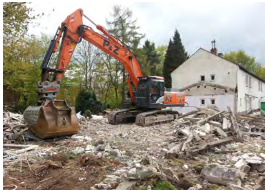
Bagger verrichten ihre Arbeit: Im April d. J. werden als erste die Häuser Alte Landstraße 237-243 aus den 50er Jahren abgerissen.
