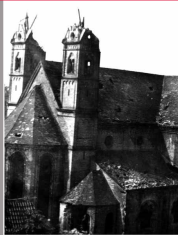
Im März 1945 lag Kaiserswerth unter langem und heftigem Artilleriebeschuss von der gegenüber liegenden Rheinseite her. Besonders hart traf es die direkt am Rhein liegende Süilbertuskirche
