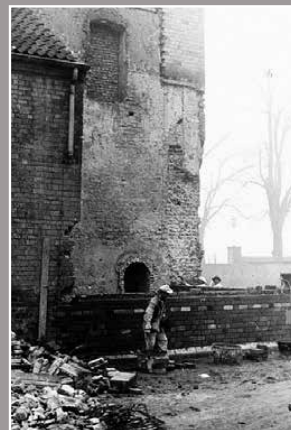
Die Entscheidung war gefallen: Die Glocken sollen zukünftig in einem neuen Dachreiter ihren Platz finden. Jetzt wurden auch die Reste der Westtürme abgetragen und die beiden Seitenschiffe verlängert
